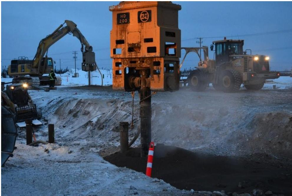
**FIGURA 24 INSTALACIÓN DE PILOTES HELICOIDALES A TRAVÉS DE PERMAFROST (IMAGEN CORTESÍA DE AMERICAN PILE DRIVING EQUIPMENT).**
