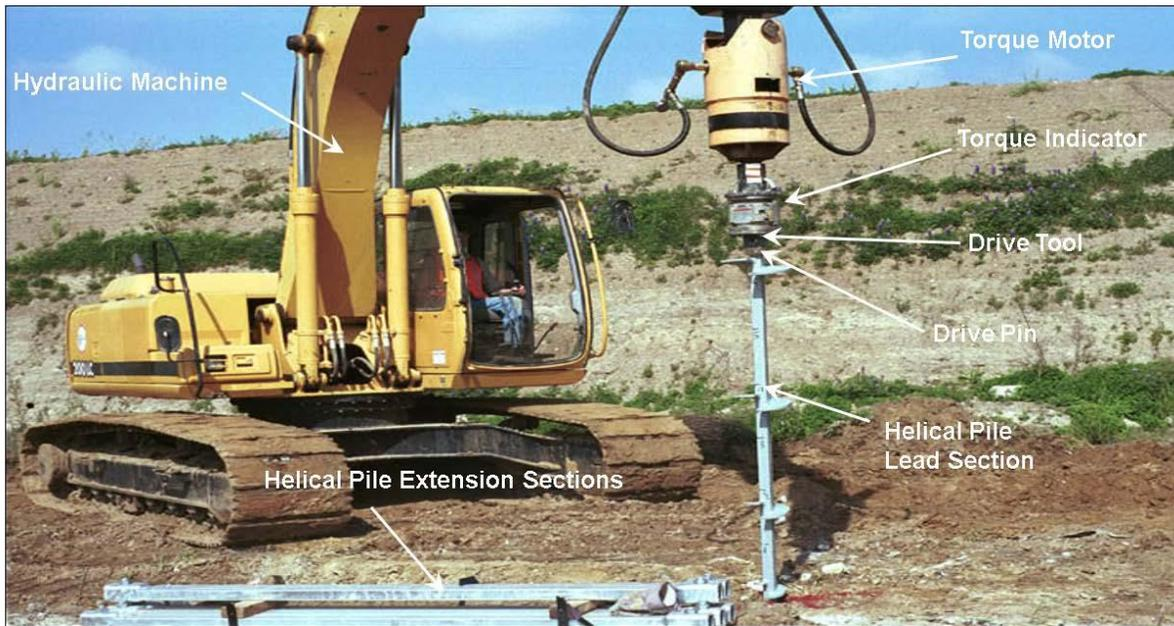
FIGURA 10 MÁQUINA HIDRÁULICA TÍPICA Y MOTOR DE TORSIÓN PARA LA INSTALACIÓN DE PILOTES HELICOIDALES (CORTESÍA DE HUBBELL POWER SYSTEMS, INC.)
