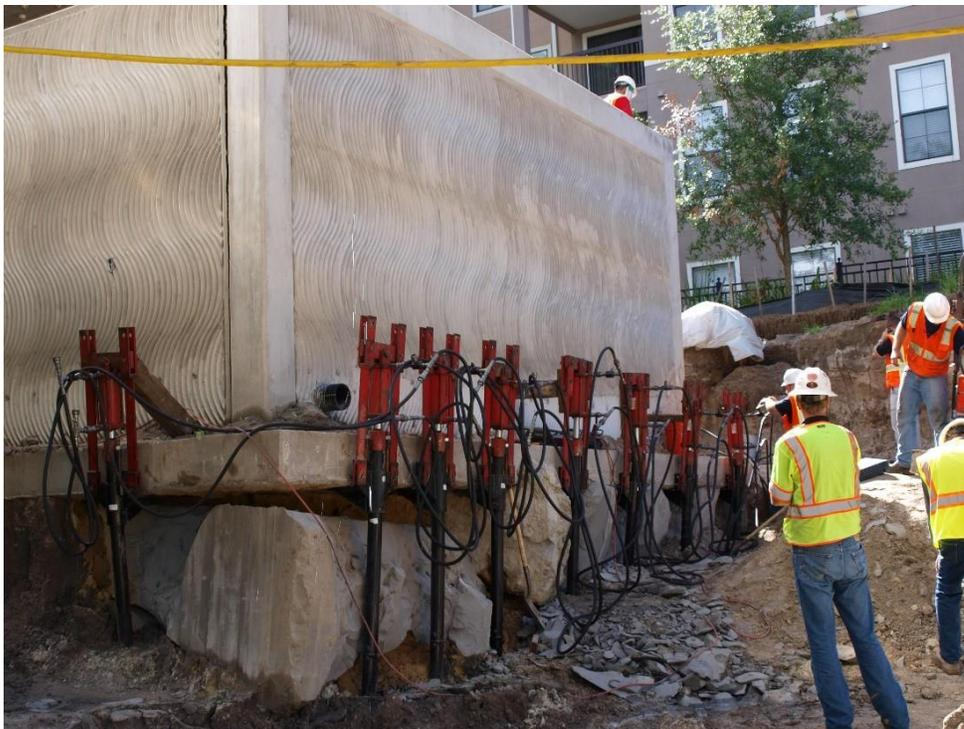
**FIGURA 9 ELEVACIÓN DE UNA ESTRUCTURA APUNTALADA MEDIANTE PILOTES HELICOIDALES (IMAGEN CORTESÍA DE RAMJACK).**
