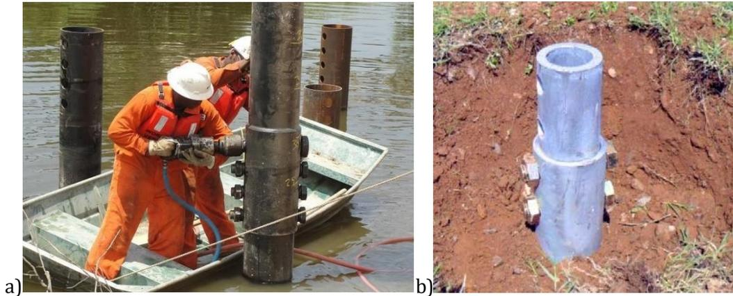
**FIGURA 5 ACOPLADORES TÍPICOS PARA PILOTES HELICOIDALES, A) ATORNILLADOS CON MANGUITO DE TUBERÍA EXTERNO SOLDADO (IMAGEN CORTESÍA DE MASON CONSTRUCTION), B) ATORNILLADOS CON MANGUITO DE TUBERÍA INTERNO (IMAGEN CORTESÍA DE FOUNDATION SUPPORTWORKS, INC.).**
