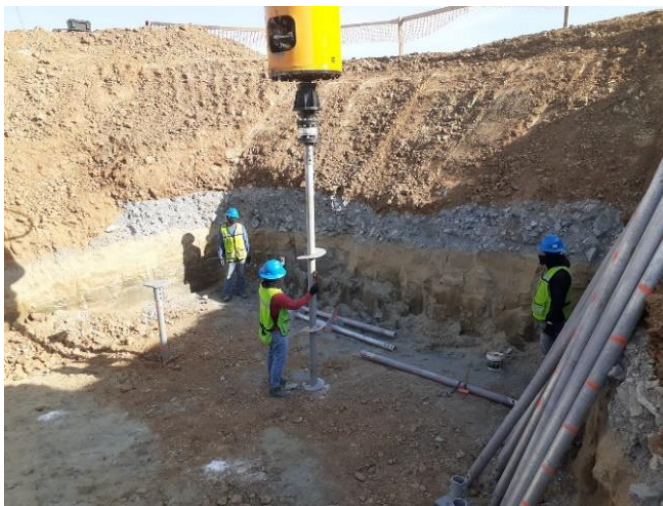
Figura 11. Nivelación de sección principal para su hincado.
