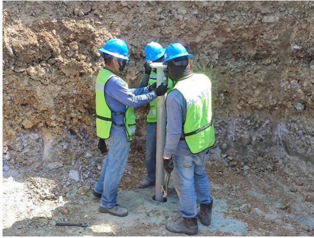
Figura 13. Instalación de conector de cabeza cuadrada.
