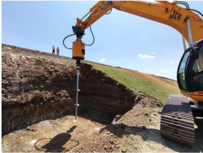
Figura 10. Instalación de sección principal con 3 hélices.
