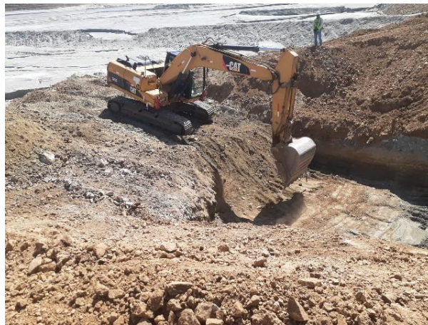
Figura 14. Excavación extra para la colocación de las pilas helicoidales.
