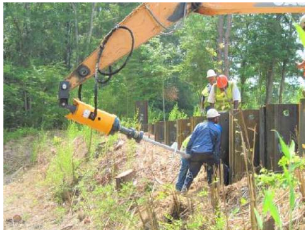
Figura 4. Equipo de instalación.
