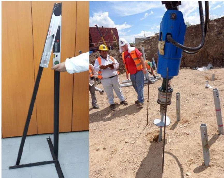
Figura 2: Uso de guías o barras laterales durante la instalación de una pila helicoidal (derecha) y una foto de un trípode de nivelación (izquierda).
