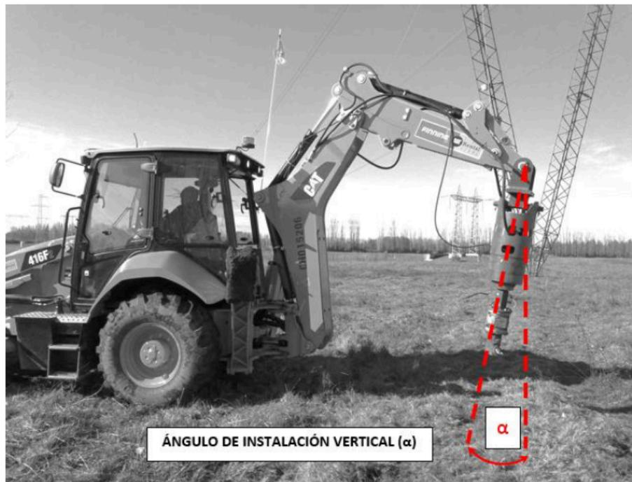
Figura 1: Ángulo de instalación vertical de una pila helicoidal.
