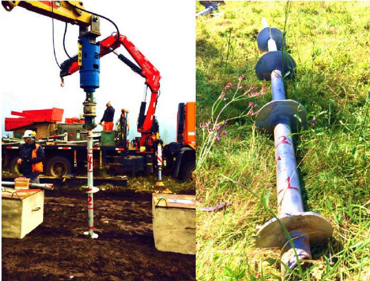
**Figura 5: Pilote helicoidal marcado cada 1 [ft] a lo largo de toda su extensión (derecha) y pilote helicoidal marcado durante su instalación (izquierda).**
